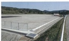
▲ 造成後の敷地全景
