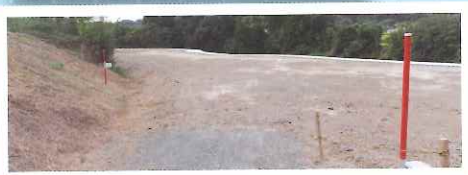
▲河川漏水センサー 設置2基
